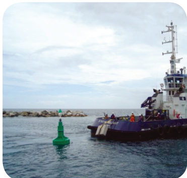
Instalación de la Boya Poseidon Sealite, equipada con una linterna SLC310, Sint Maarten
